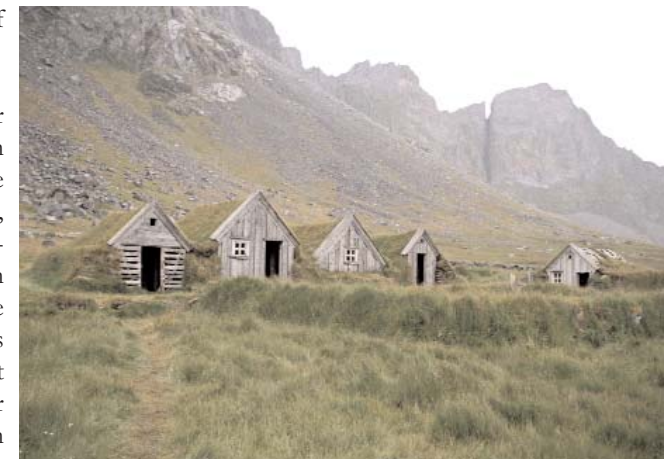
Aufgelassene Behausungen zeigen die einstige Bauweise in Island
